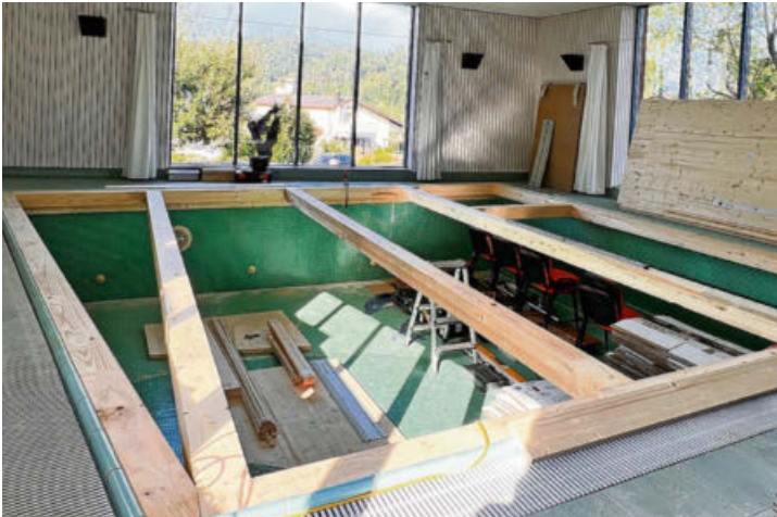
Im Sommer haben die neuen Eigentümer das Bad umgebaut.
